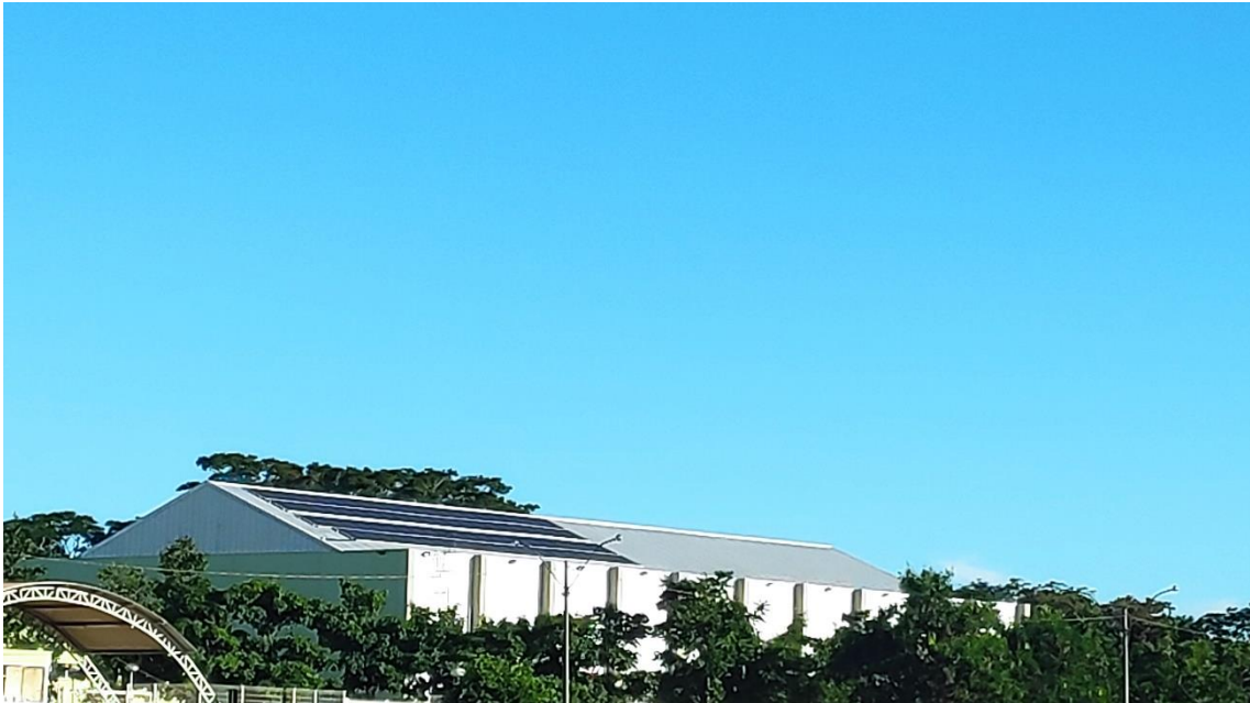
Foto 4. Sistema fotovoltaico II – 30 kWp.
