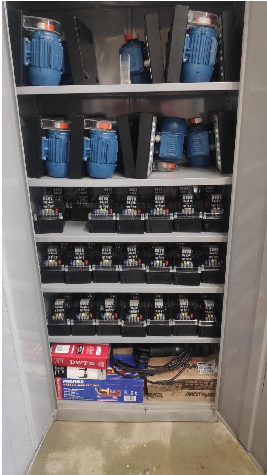
Foto 73. Infraestrutura de laboratório.
