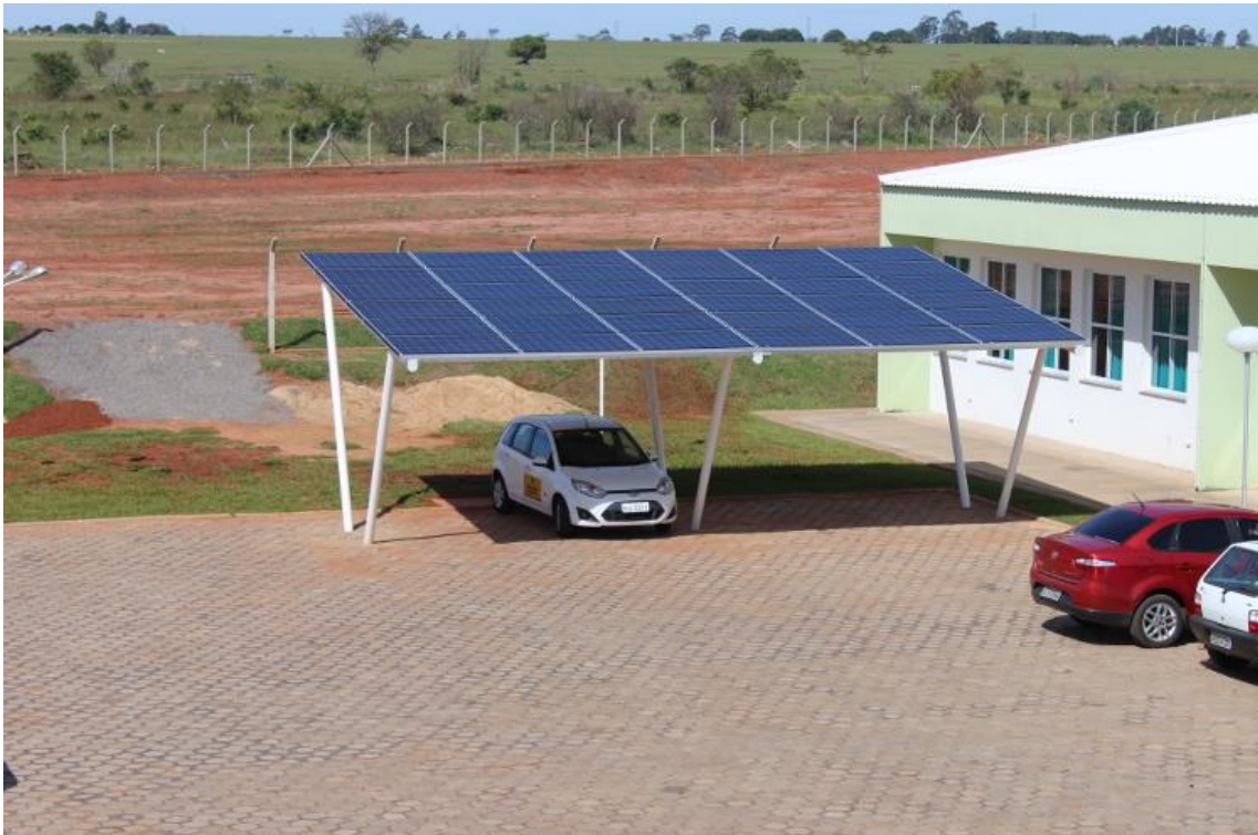
Foto 5. Sistema fotovoltaico III – 7,95 kWp.
