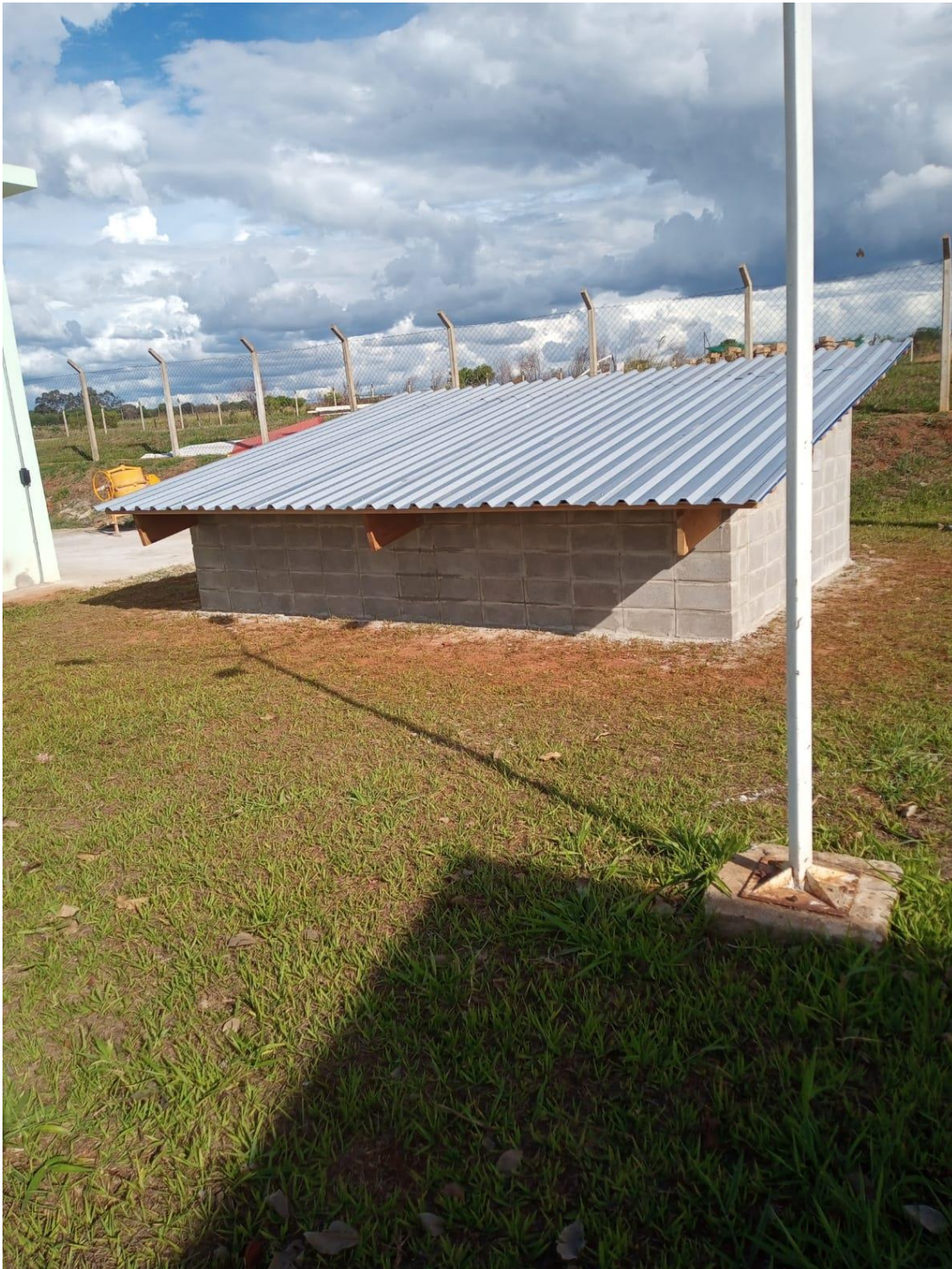
Foto 136. Infraestrutura de laboratório (telhado_fotovoltaico).
