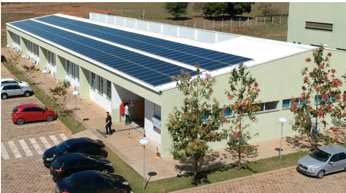
Foto 3. Sistema fotovoltaico I – 75 kWp.
