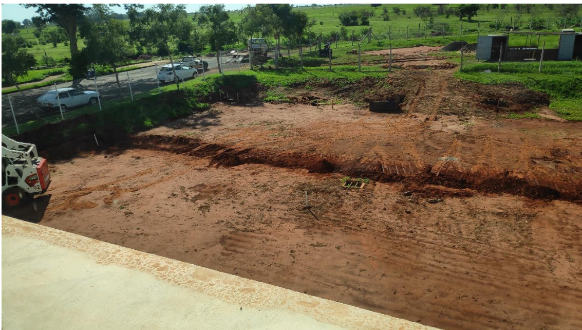
Foto 138. Construção de dois blocos novos de salas/laboratórios (2022).
