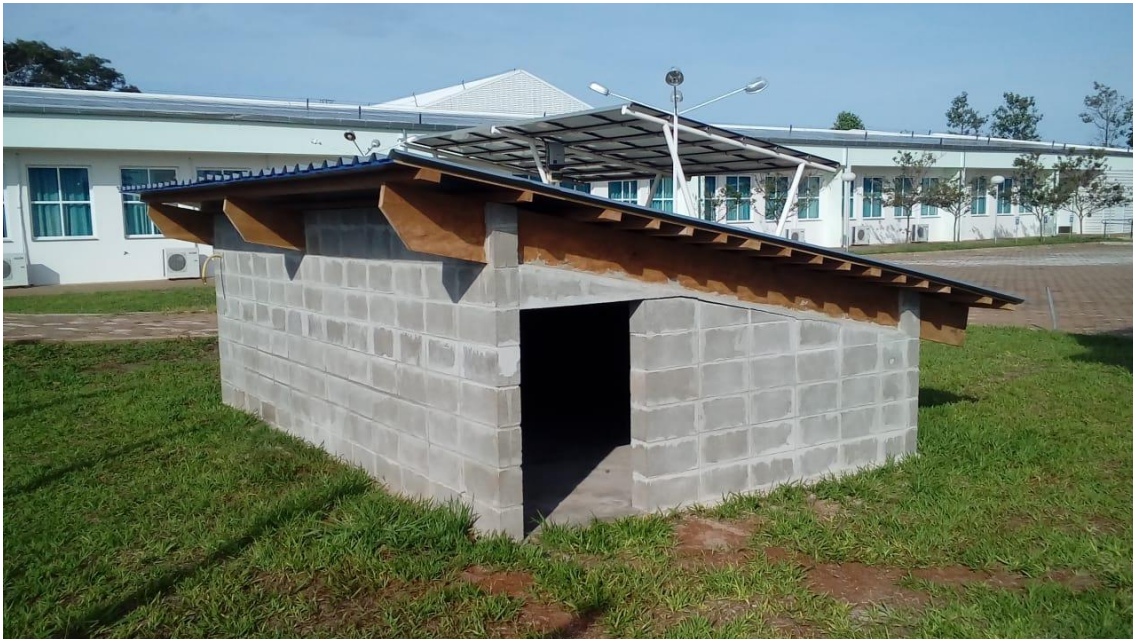
Foto 137. Infraestrutura de laboratório (telhado_fotovoltaico).
